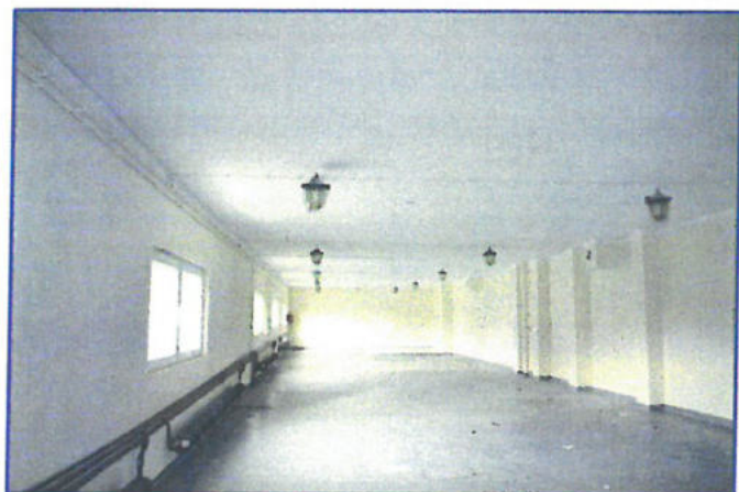
BUDYNEK BIUROWY – I PIĘTRO
