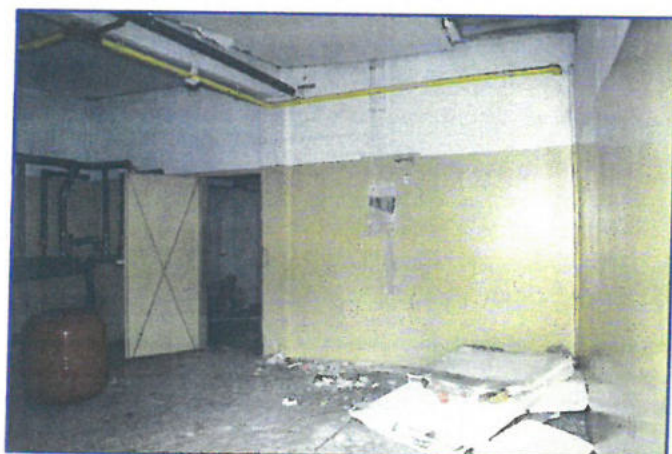
BUDYNEK BIUROWY - PRZYZIEMIE
