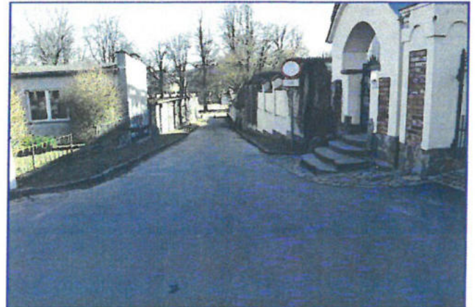
DROGA DOJAZDOWA - UL. GRUNWALDZKA
