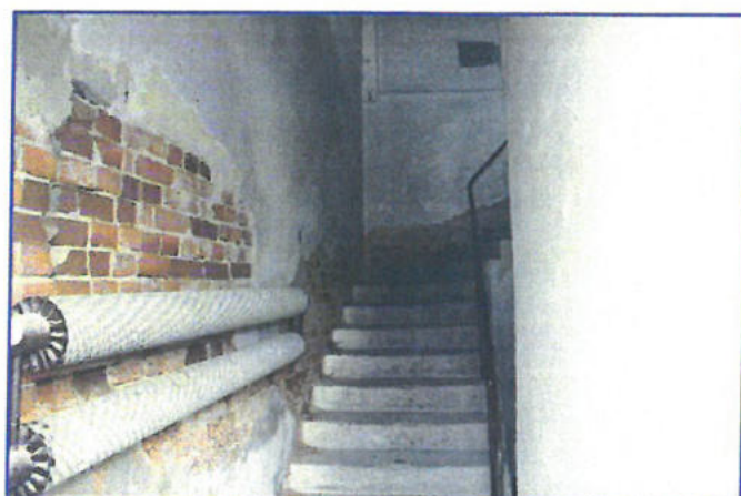
BUDYNEK BIUROWY – I PIĘTRO
