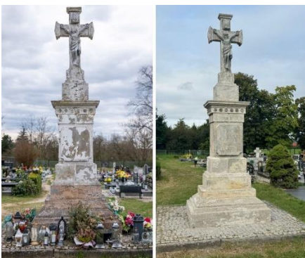
Przed pracami konserwatorskimi oraz po pracach konserwatorskich (fot. Daniel Frymark)
