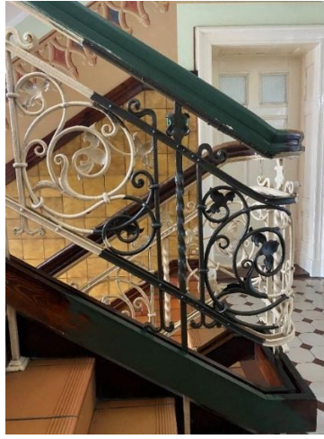
próby kolorystyki klatki schodowej
