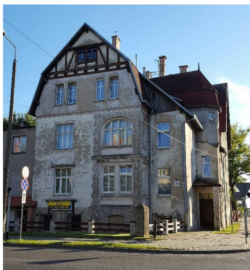
Stan obiektu przed pracami
