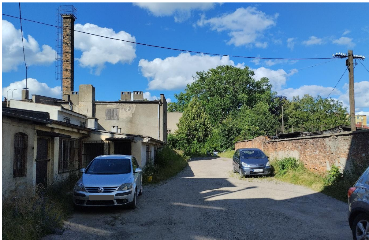
Fot. 3. Podwórko przy ul. Dworcowej, w którym znajduje się teren zdegradowany wykorzystywany wcześniej gospodarczo źródło: zbiory własne.
